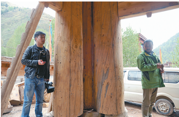
工作人员测量房屋。
