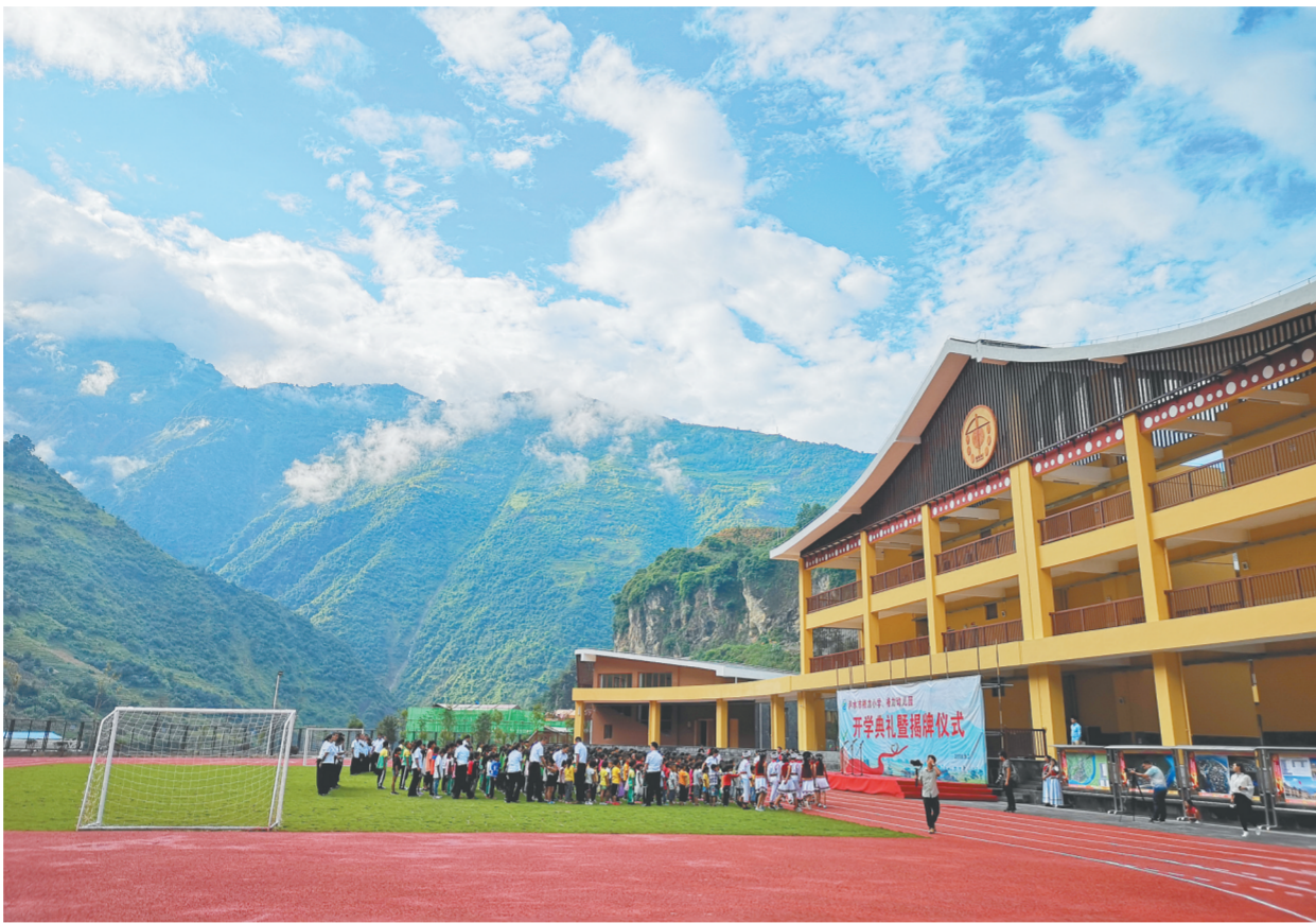
云南怒江傈僳族自治州泸水市大兴地镇维拉坝珠海社区配套的格力小学。新华社发
