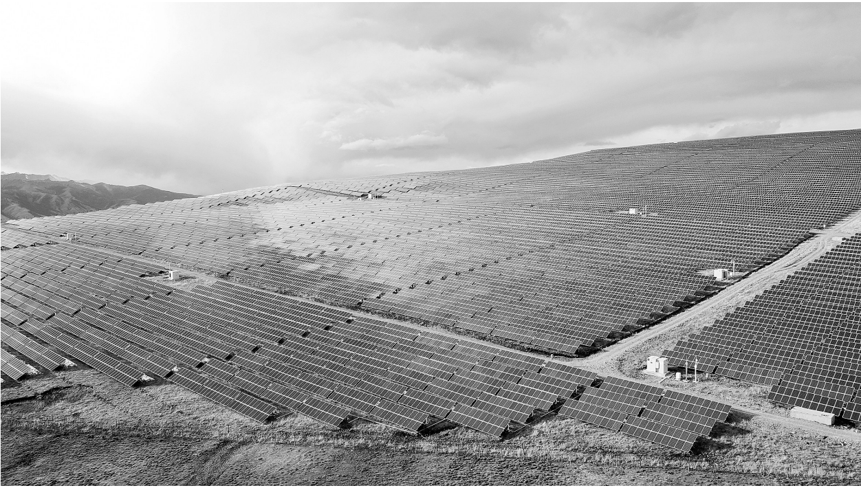
炉霍县贡唐岗光伏电站。凌小柯 甘孜日报记者 肖宵 摄
