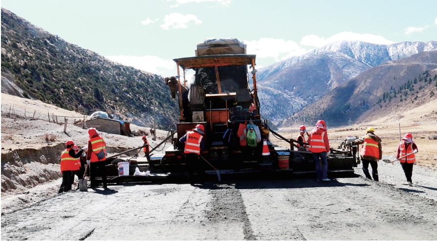
图为道路建设施工现场。
