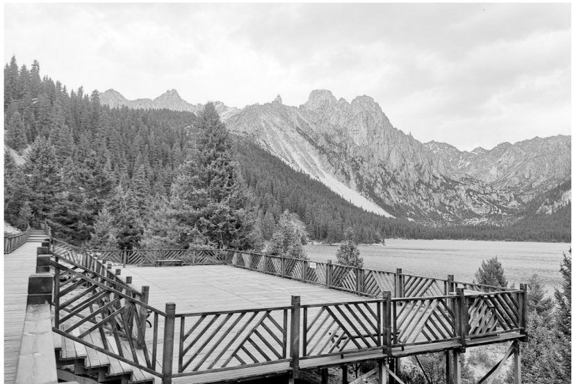
巴塘县措普沟景区栈道完成建设。
