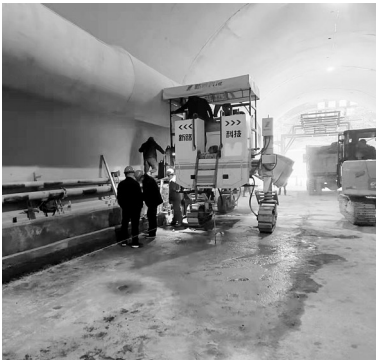
电缆沟滑模设备。
