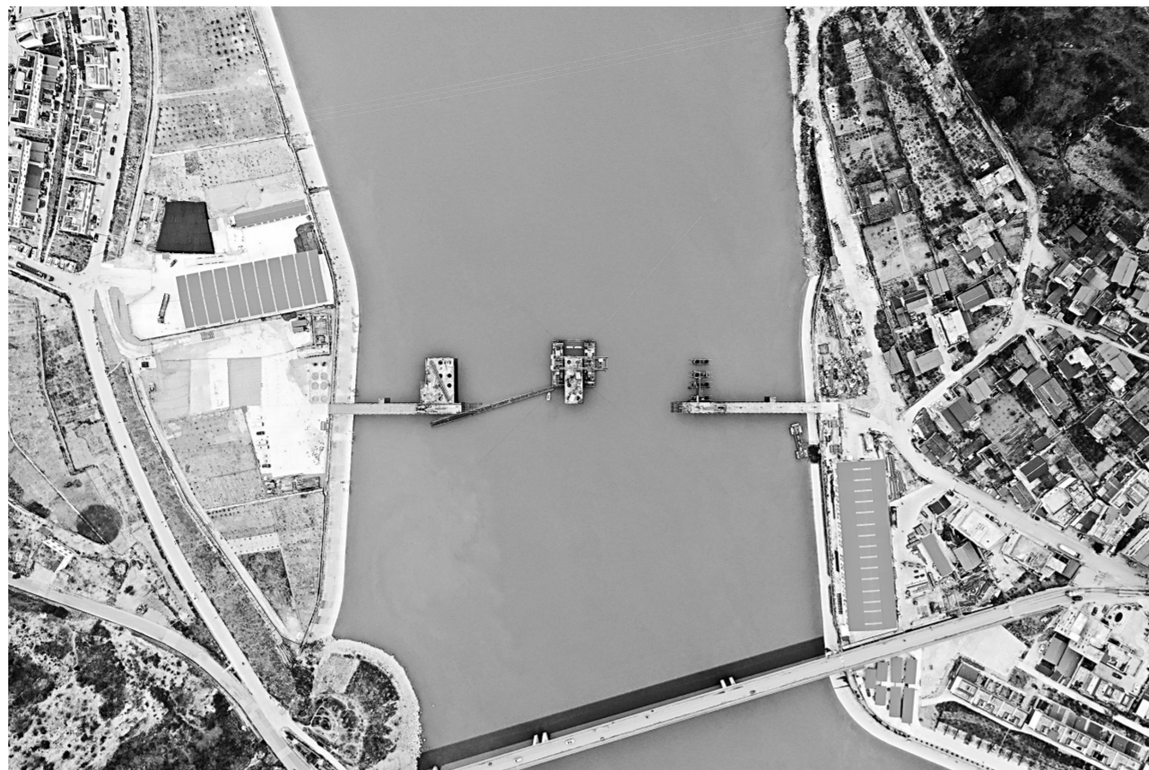
泸石高速得安特大桥建设现场。
