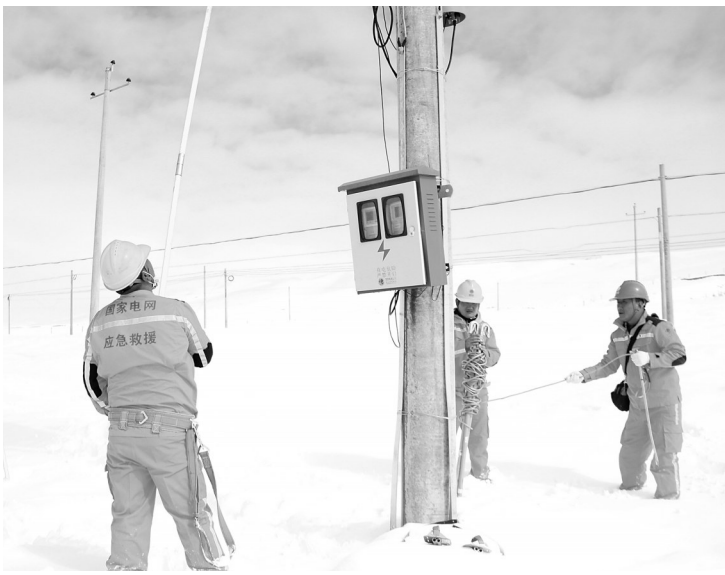
修复受损线路。
