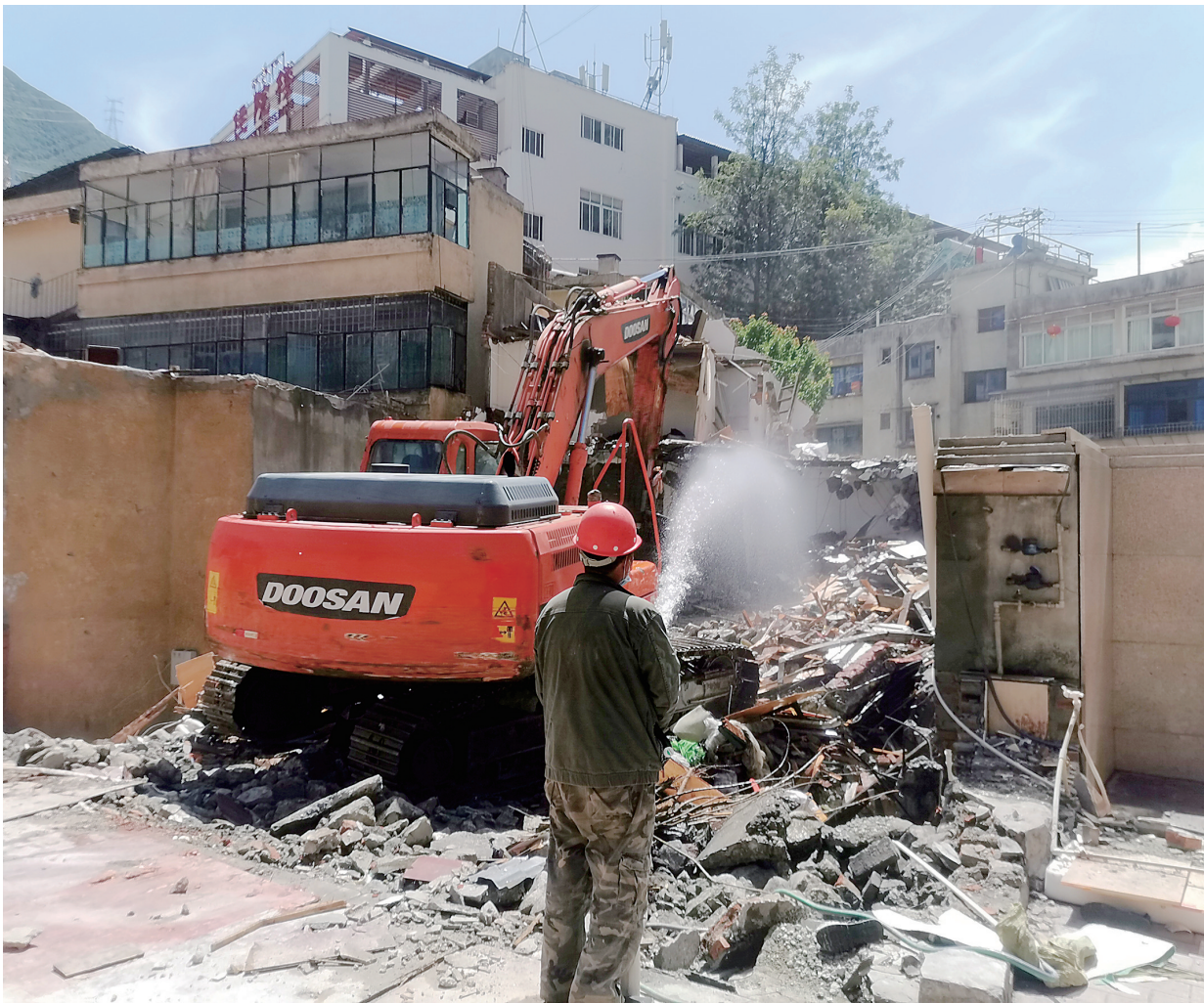
图为拆迁现场。
