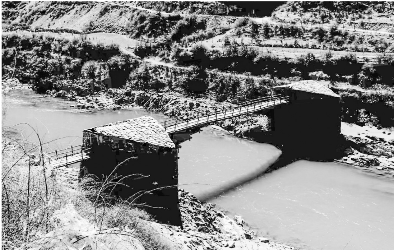
图为新龙县波日桥全景。宏图多吉 摄
