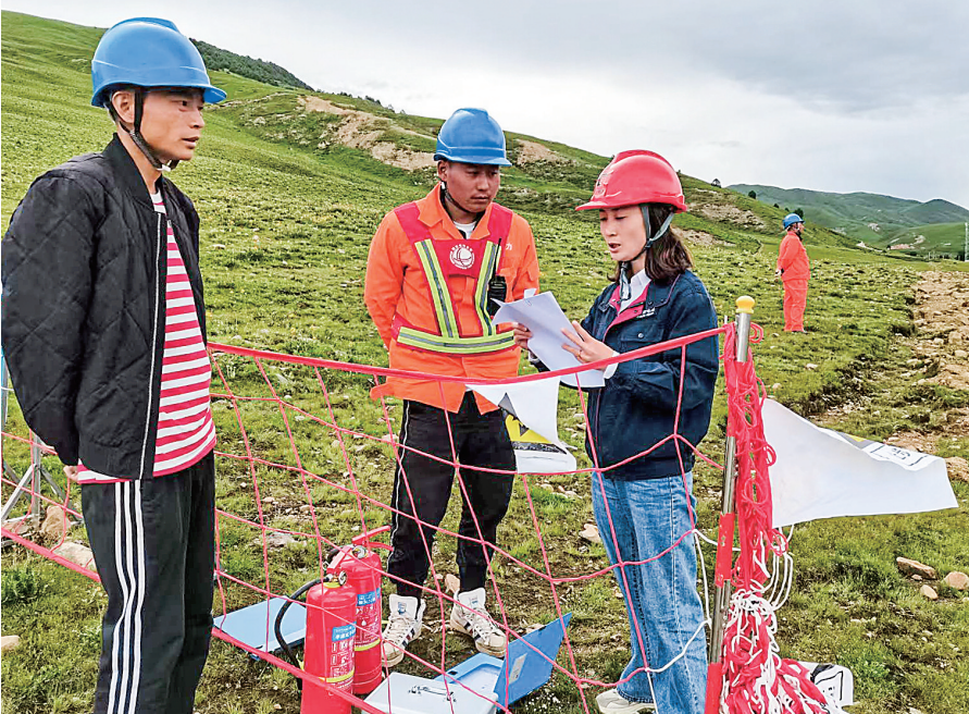
杨兴玉在施工现场开展检查。
