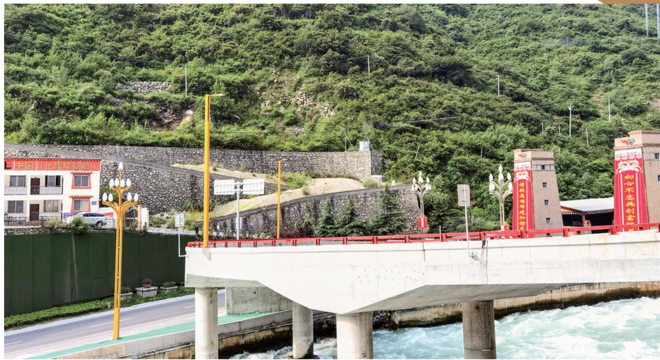
曾经的海船石地段，如今是过境公路立交桥。
