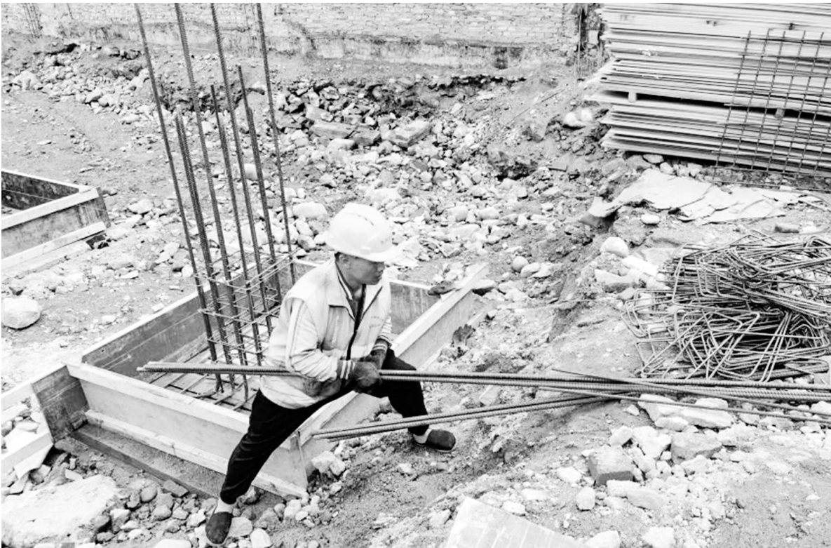
图为得妥镇金光村灾后重建项目施工现场。
