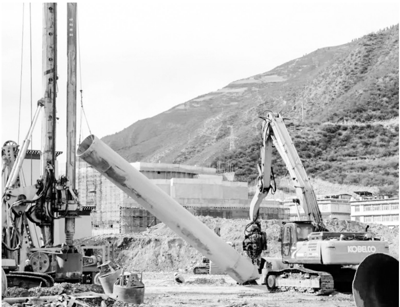
图为白玉县河坡民族手工艺文旅融合示范园区项目施工现场。
