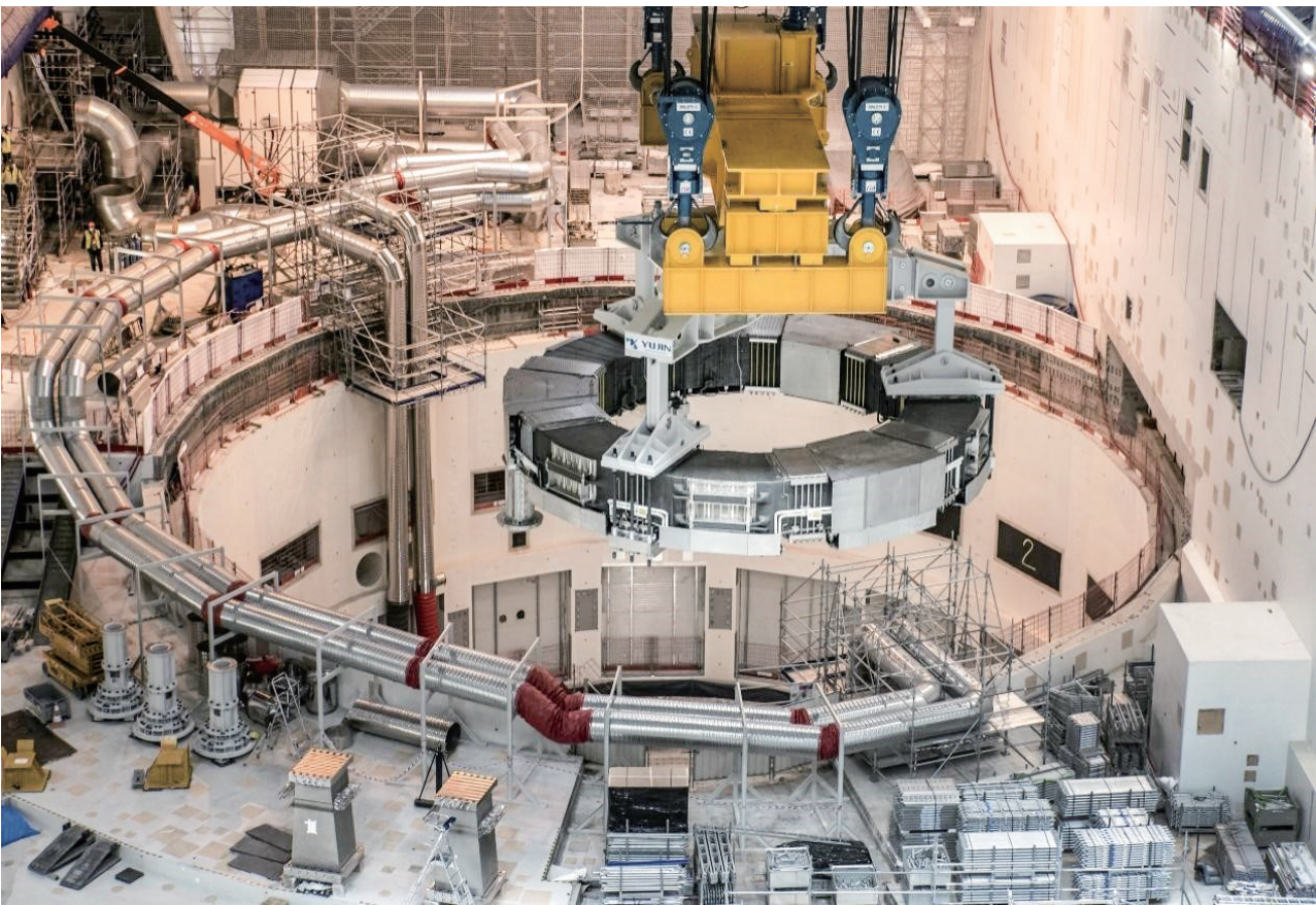
2021年4月,中国研制的PF6超导磁体线圈在法国ITER项目现场吊装。新华社 发
