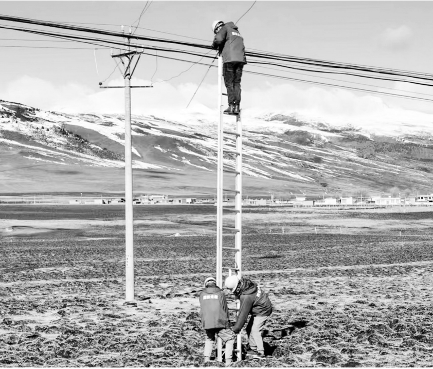
工作人员正在进行线路维护。
