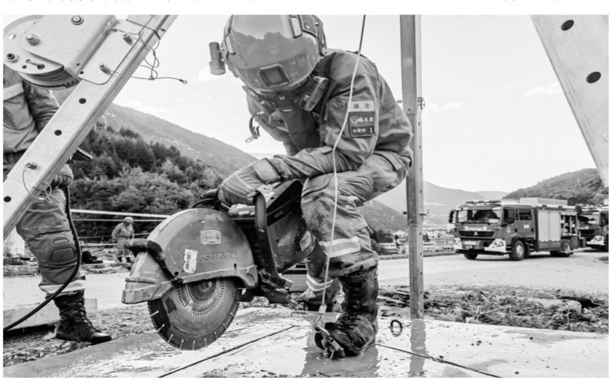
开展顶升、横向快速破拆技术救援行动。
