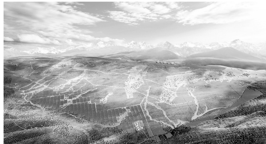
三峡道孚县光伏工程鸟瞰。本报资料库图
