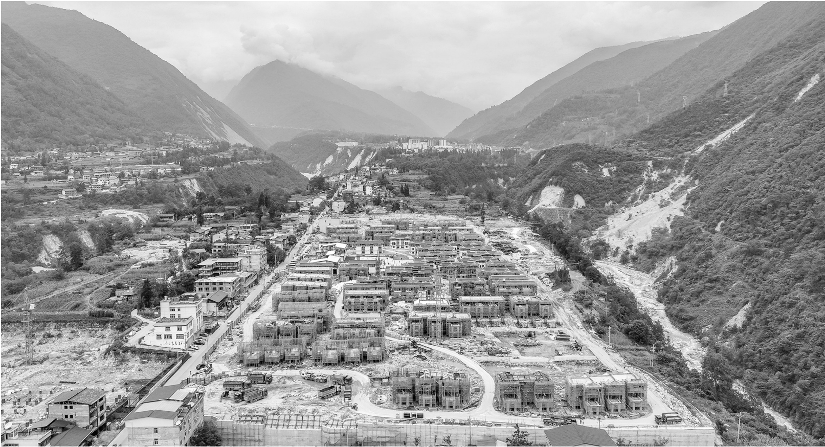
建设中的磨西大杉树安置点。
