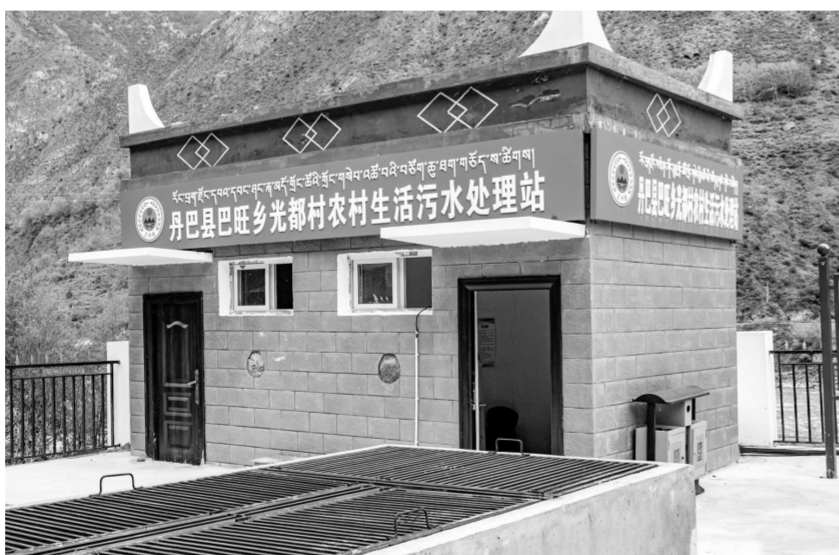
生活污水处理站。洛绒尼玛 摄
