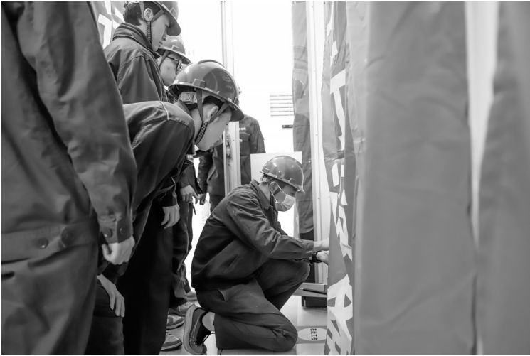
不停电调试作业现场。
