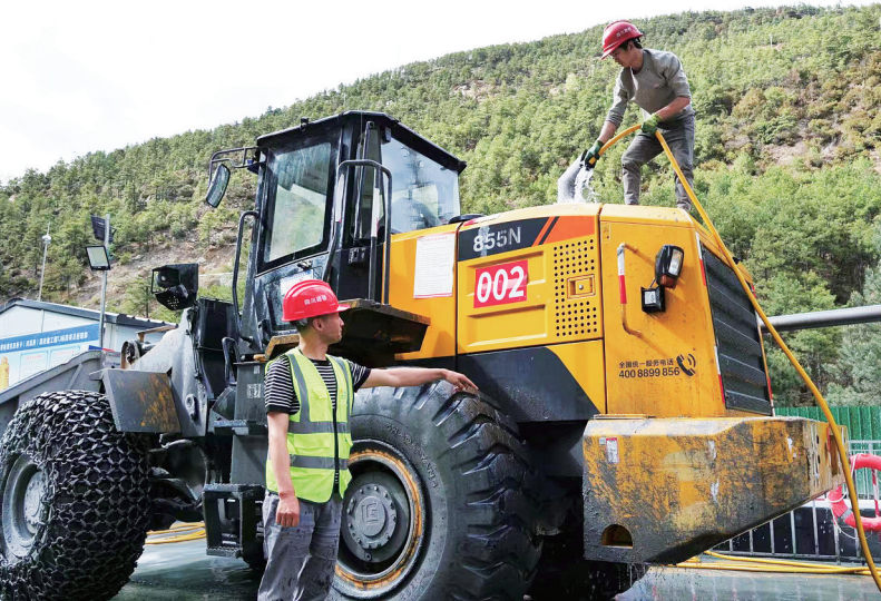
省道463俄初山越岭段大修工程施工现场。
