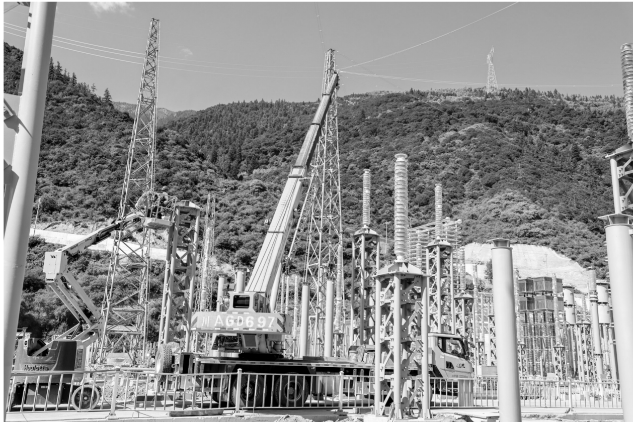
工程建设现场。
