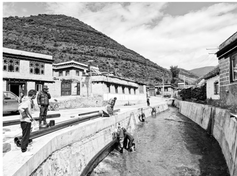
图为驻村工作队正在组织人员安装排污管道。
