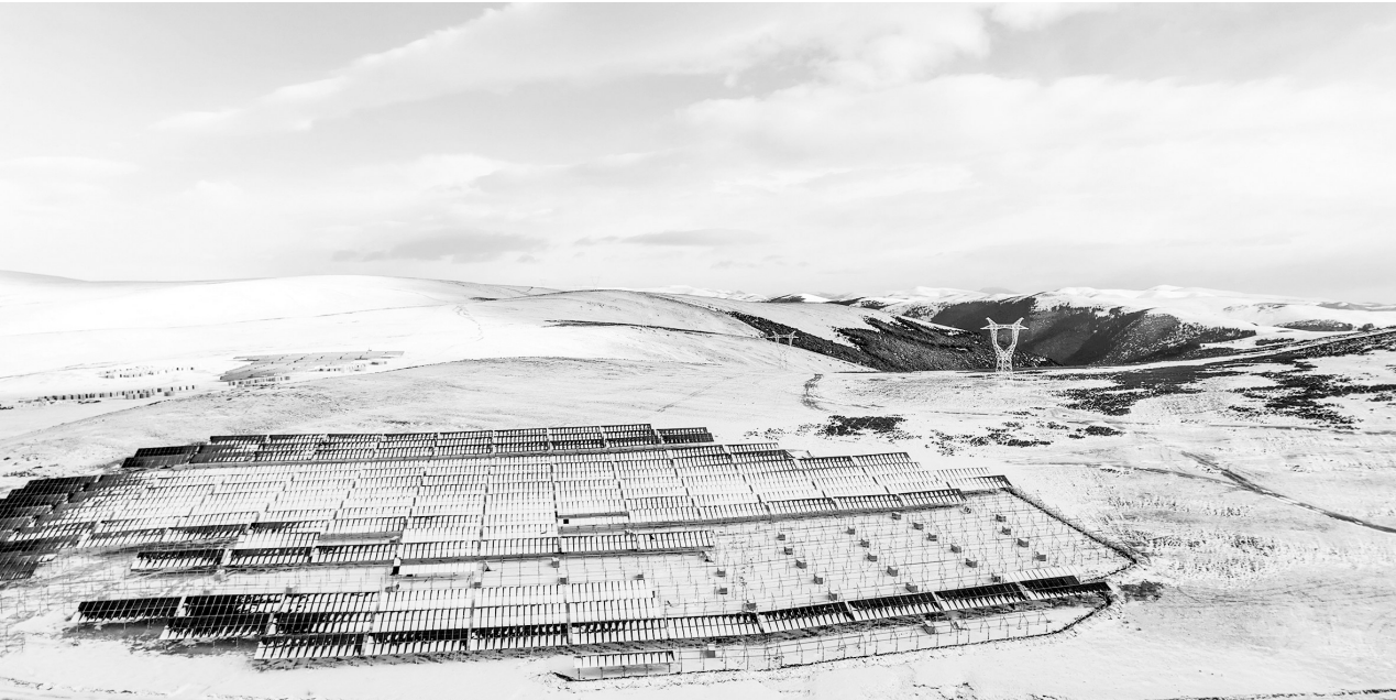
全球最大、海拔最高的水光互补电站——雅砻江柯拉光伏电站。贾洪恩 摄
