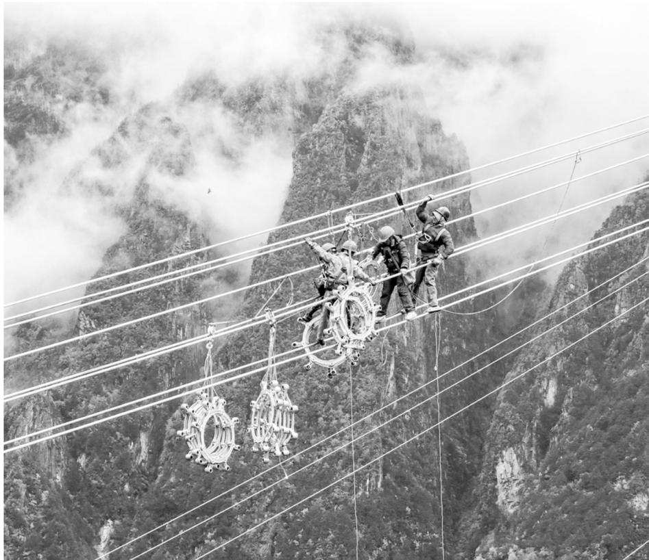
电网员工正在高空开展安装间隔棒作业。
