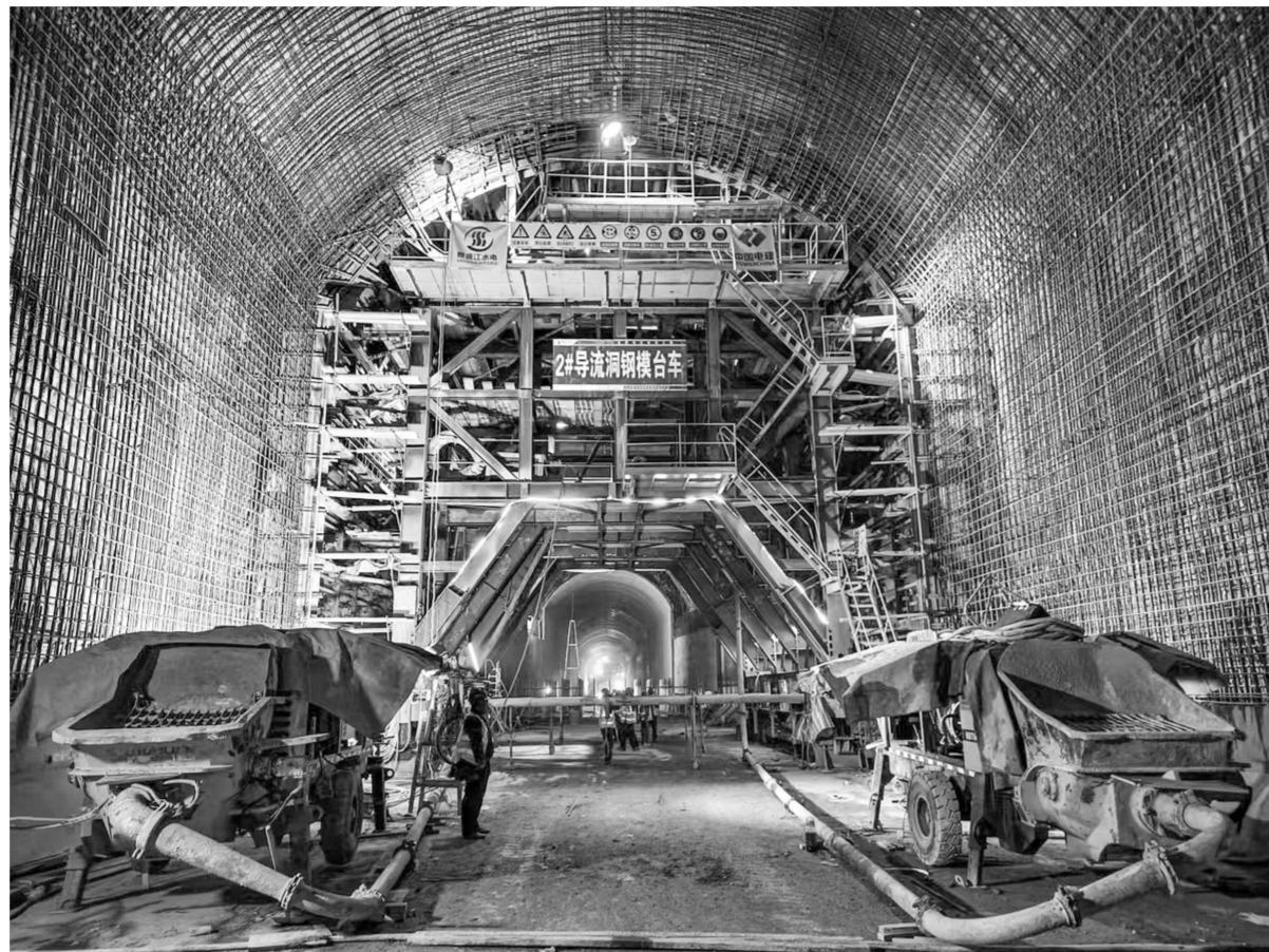
图为孟底沟水电站建设现场。
