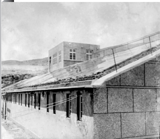
这是1981年原甘孜大站建成的太阳能浴室。
