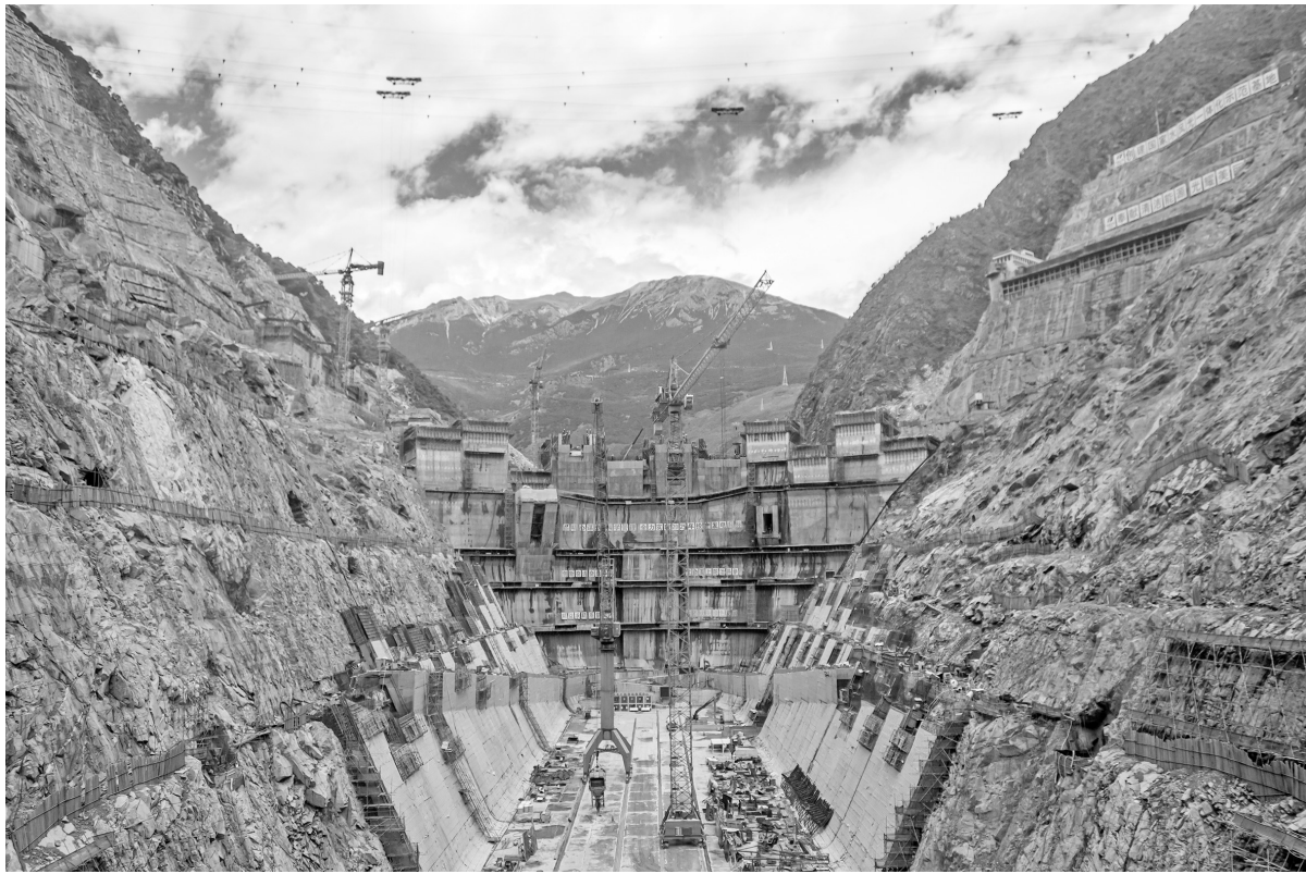
正在建設中的葉巴灘水電站。
