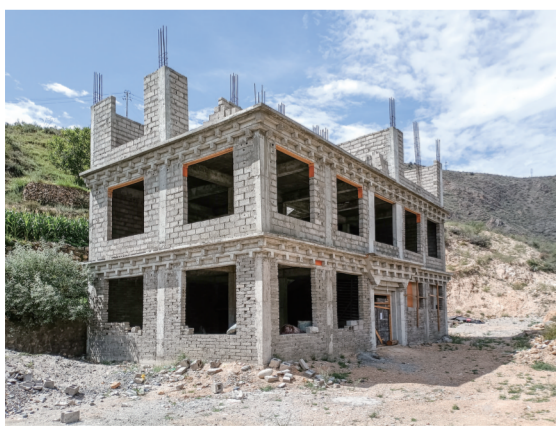
夏邛镇茶雪村房屋现场照片(第二栋)
