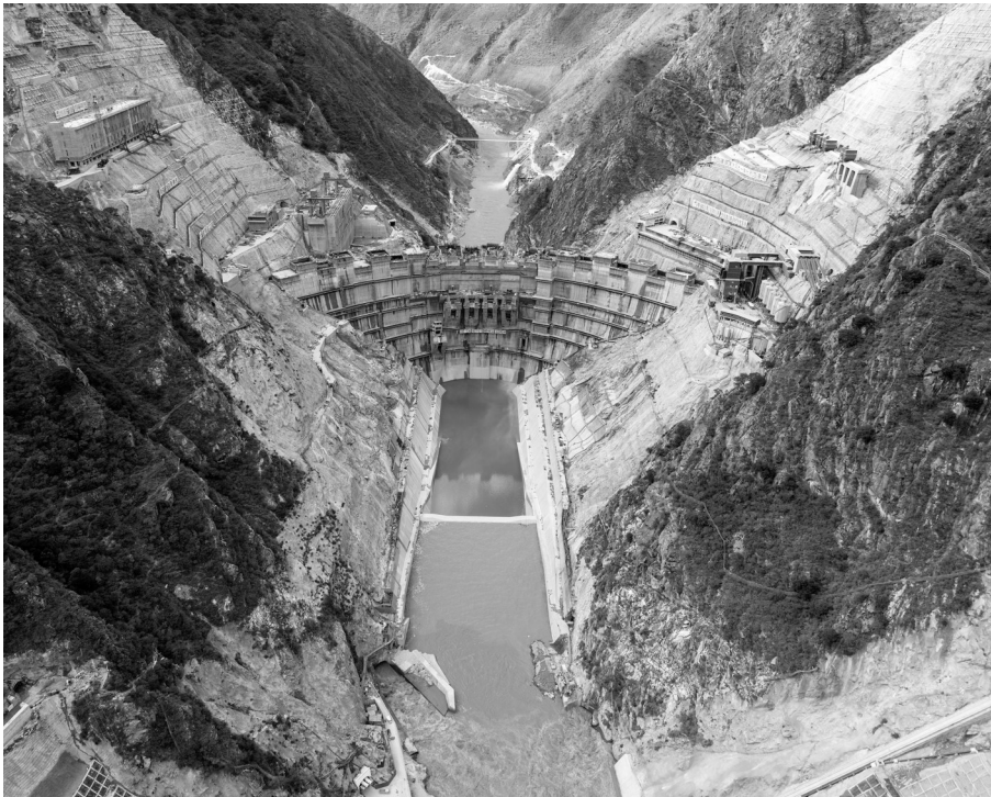
在建的葉巴灘水電站
