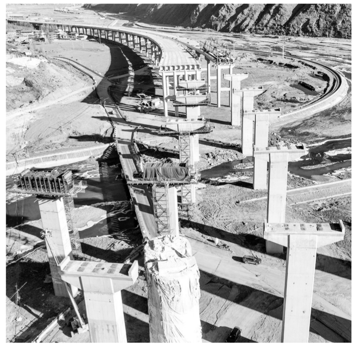
建设中的康新高速公路新都桥互通枢纽。
