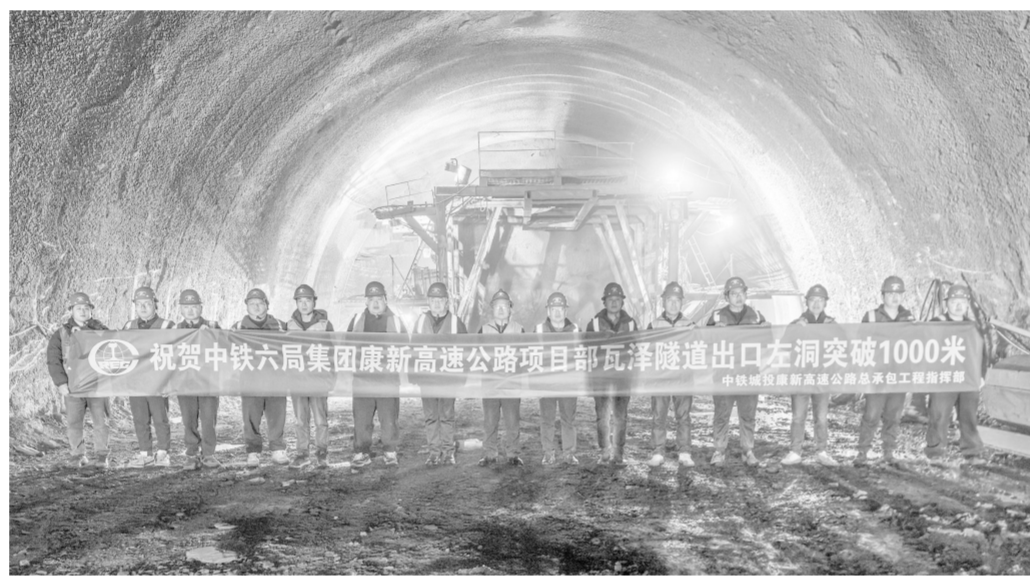
瓦泽隧道出口左洞掘进顺利突破一公里。
