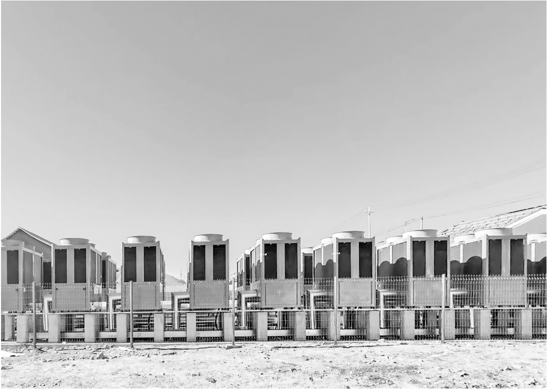
色达县低温空气源热泵设备。
