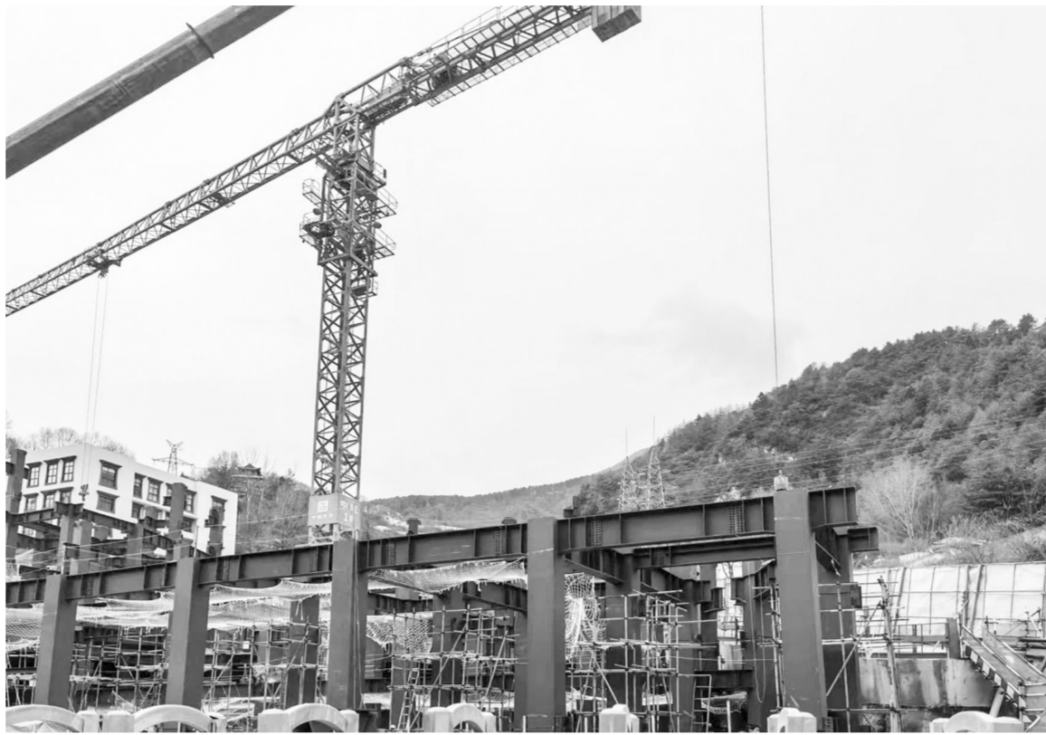
游客集散中心施工现场。
