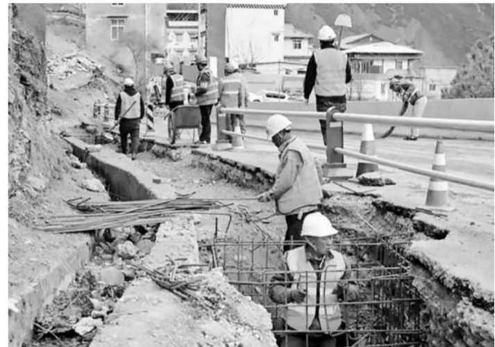
施工现场如火如荼。
