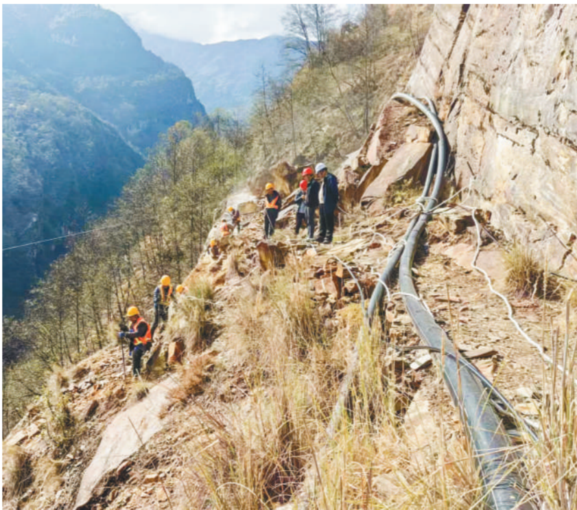
九龙县挖脚(烟袋)引水工程勉多镇施工现场。
