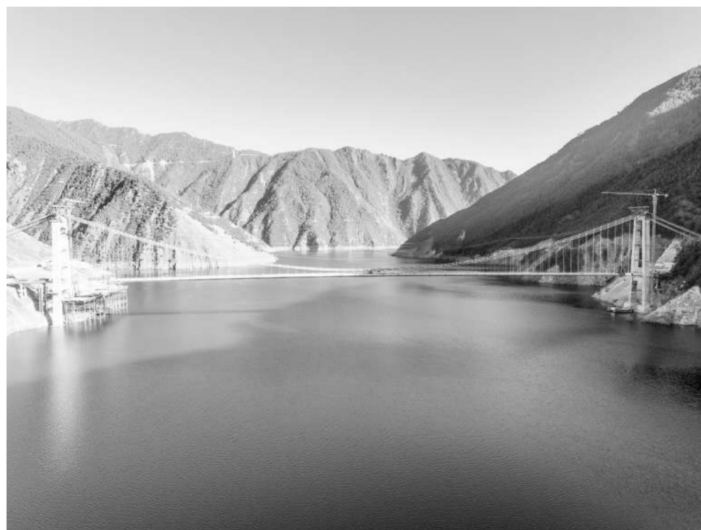
雅砻江特大桥顺利合龙。
