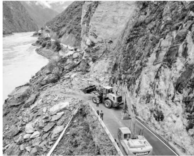
大型机械助力抢险保通。
