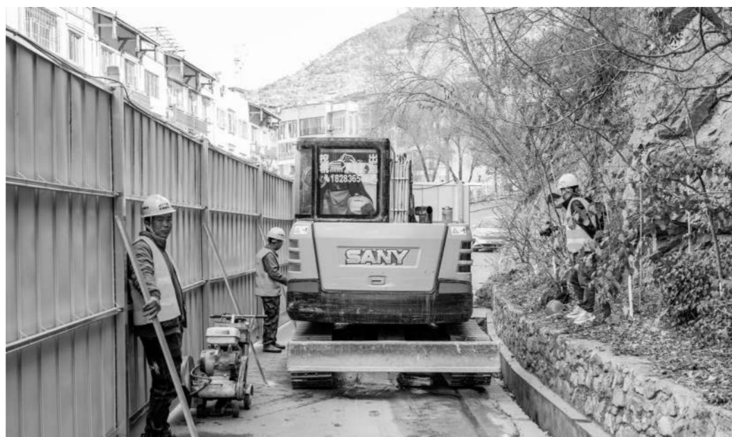
地下管网更新施工现场。泸定县委宣传部供图
