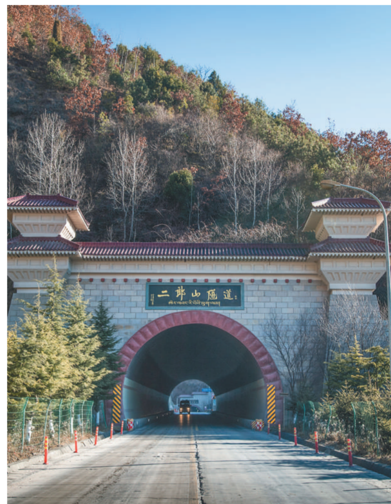
泸定二郎山隧道西口。
