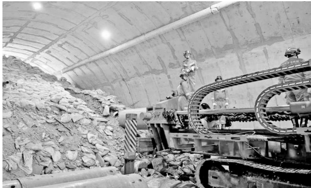
应急救援队员开展隧道抢险科目。
