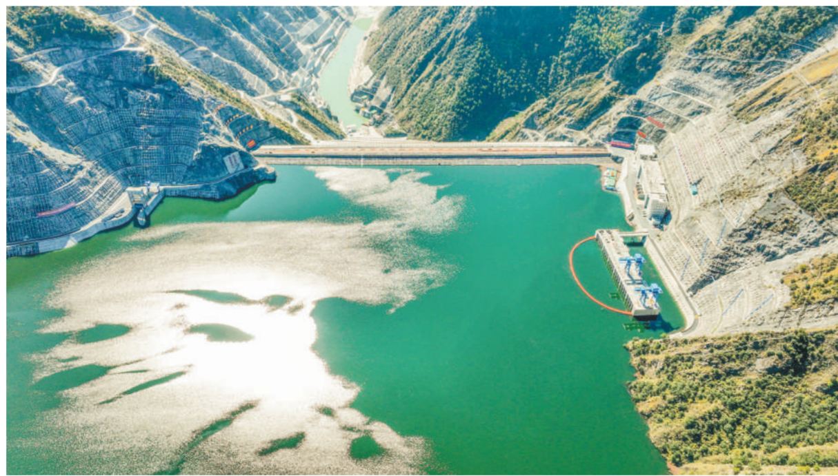
俯瞰两河口水电站。本报资料库图
