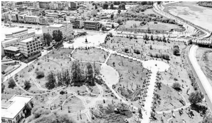
图为施工现场。
