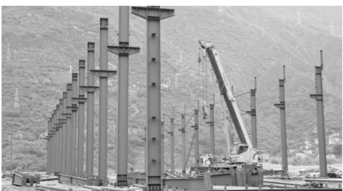
吊车进行梁体架设作业。
