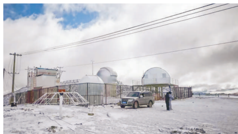
全球海拔最高的跨圈层综合观测站一角。
