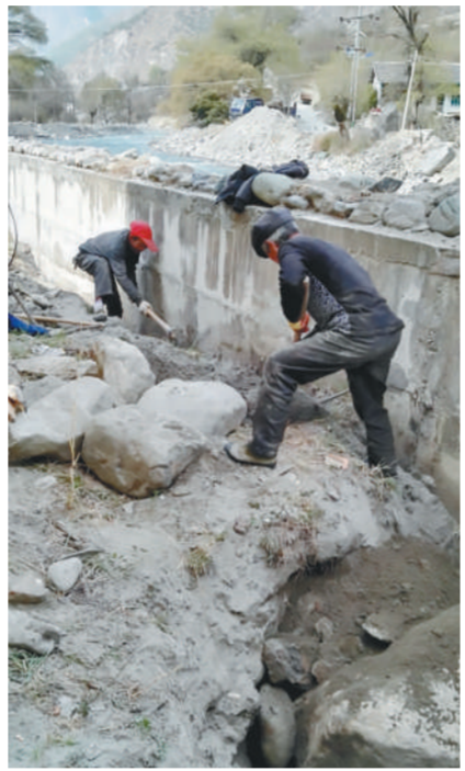
修建杨家河坝河堤。
