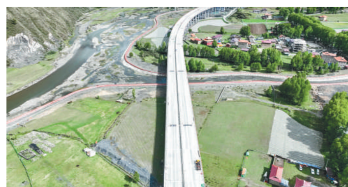
建设中的康新高速新都桥互通枢纽B1匝道特大桥。
