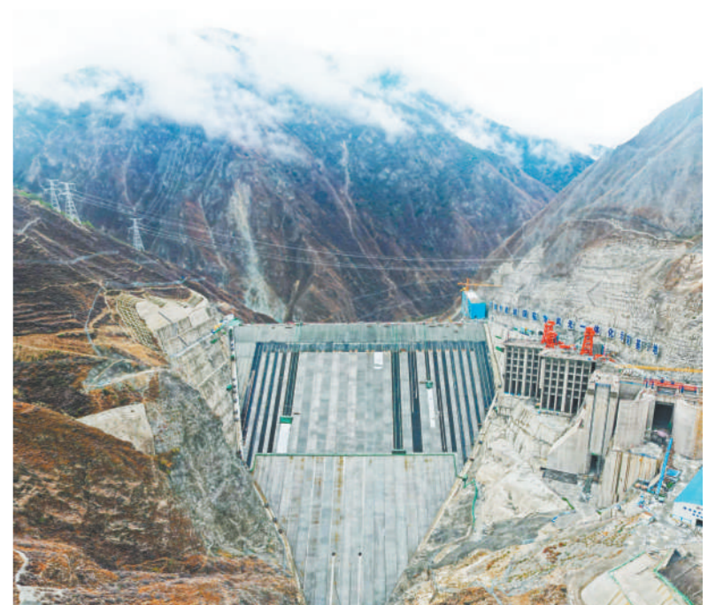
建设中的拉哇水电站。
