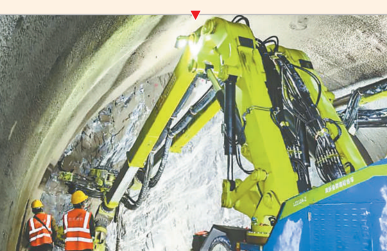
凿岩台车操作手正在施工作业。
