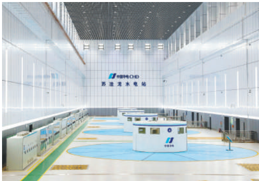
苏洼龙水电站机组安装实现“零配重”，在额定转速下最大摆度仅0.05毫米。
