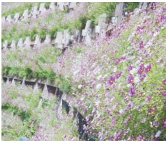
巴塘水电站垂直边坡绿化。
