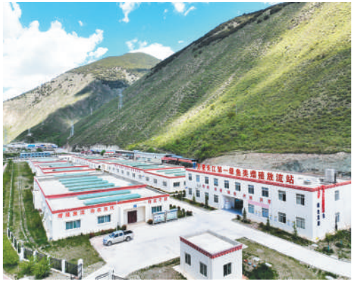
叶巴滩水电站鱼类增殖站。
