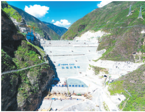
拉哇水电站大坝。
