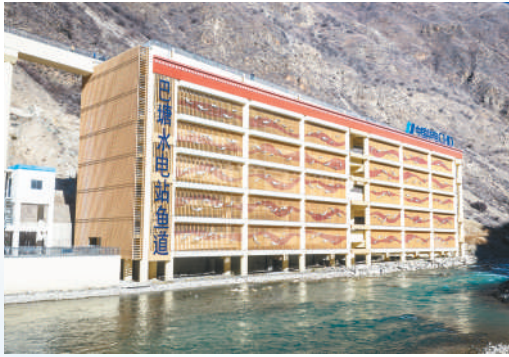
巴塘水电站鱼道。
